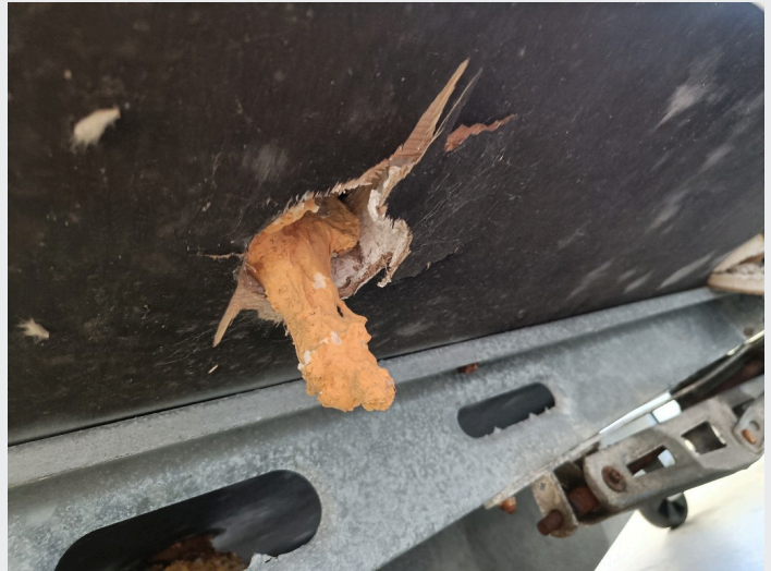
2.13 Gulv under bad har 3 hull rett inn. Ser ut som det er gjort med hullsag. Her MÅ det utbedres.
